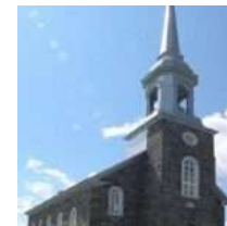
ÉGLISE SAINT-ODILON DE CRANBOURNE
